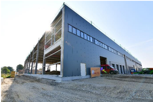
Bildunterschrift: Große Teile der anthrazitfarbenen Isopanel-Fassade sind fertiggestellt. Als nächstes folgen zudem die restlichen Türen, Tore und Fensterbänder. Bildnachweis: Firmengruppe Max Bögl
