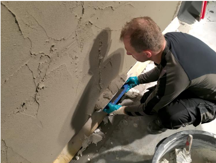
1384 – 1 Abdichtungsschicht.jpg
