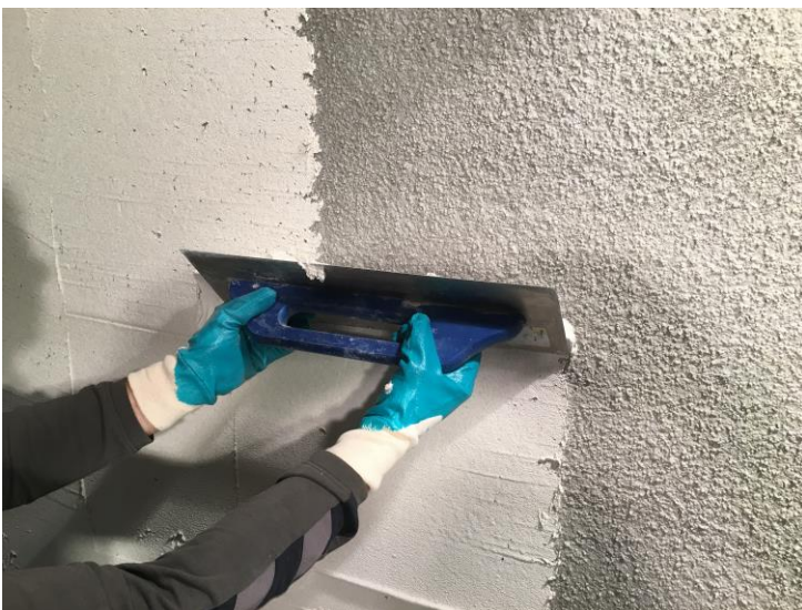
1384 – 2 Sanierputzauftrag.jpg
