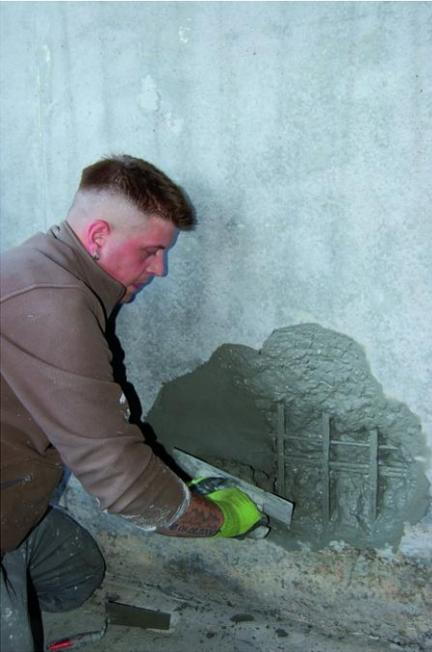
Betofix R4 SR schützt den Beton in ausgesprochen belasteten Bereichen.
