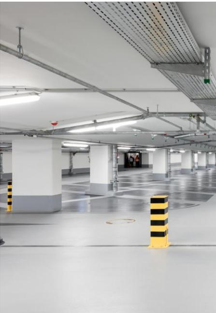
Das Remmers-System OS 2 reduziert die Wasseraufnahme sowie die Aufnahme von beton- und stahlangreifenden Stoffen.
