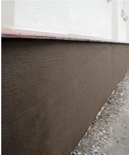
Multi-Baudicht 2K aufgetragen im Sockelbereich ist druckwasserbeständig gegenüber mehr als 1 bar Druck.
