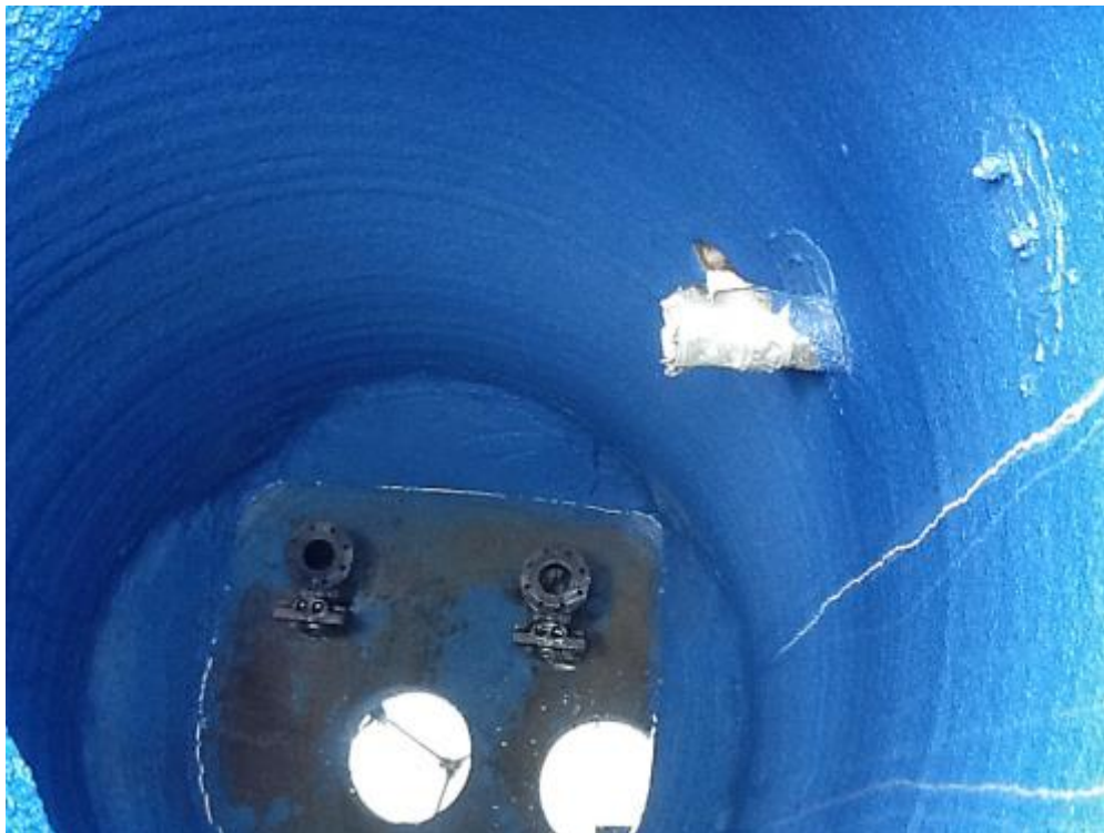
Bild 3 : Schachtkörper nach der Aufbringung der Hybrid-Silikat Beschichtung, welche eine hohe Resistenz gegenüber Chemikalien aufweist.
