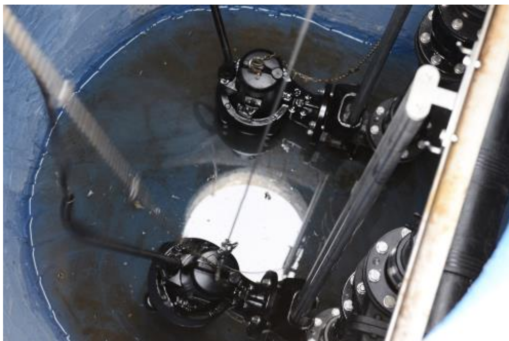
Bild 5: Einbringung der Pentair Jung Pumpen Abwasserpumpen MULTIFREE 35/4 CW1 in den Schachtkörper
