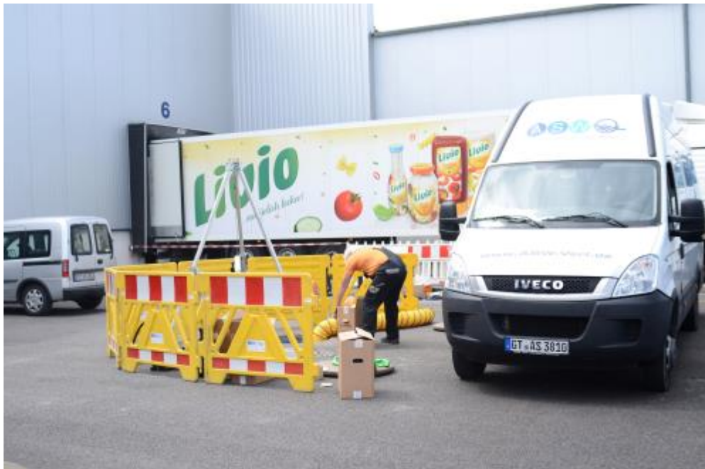
Bild 1: Schachtsanierung in Dissen bei der Spedition Flottmann. In der Nachbarschaft liegen einige fleischverarbeitende Firmen
