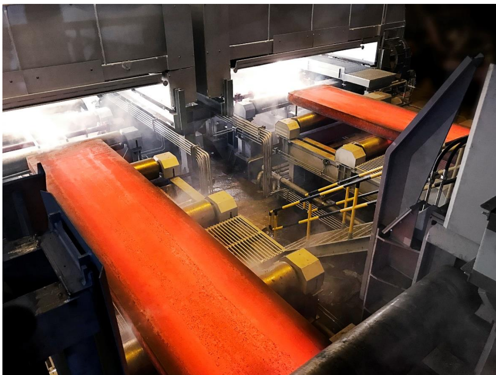
Erster Guss auf der Brammenstranggießanlage der SMS group nach erfolgreichem Umbau.
