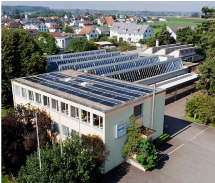
Bild Nr. 01-03 NI_WerkLuftbild.jpg
