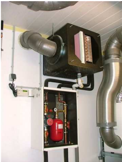
Sole-Luft-Wärmetauscher, Sole-Pumpengruppe im Gehäuse
