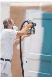
Perfekte Technik für die Praxis: Für NAST-Anwendungen bietet sich zum Beispiel das Lackieren von Garagentoren, Heizkörpern oder Türzargen an. Aber auch auf kleinflächigen Bauteilen wie Treppengeländern ist der Einsatz der nebelarmen Spritztechnologie sinnvoll. Foto: Caparol Farben Lacke Bautenschutz
