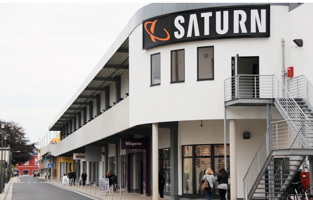
Einkaufszentrum an der Ladestraße in Hennef
