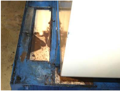
Bild Nr. 06-01 MK_KP-MazakZugang.jpg. Häufig sind die KSS-Tanks schwer zugänglich und die Reinigung von Emulsion sowie Behälter sehr aufwändig.
