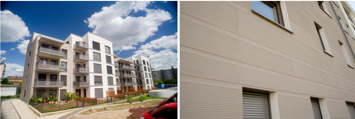
Wohnanlage in Darmstadt: „alte“ Kammputztechnik neu belebt.
