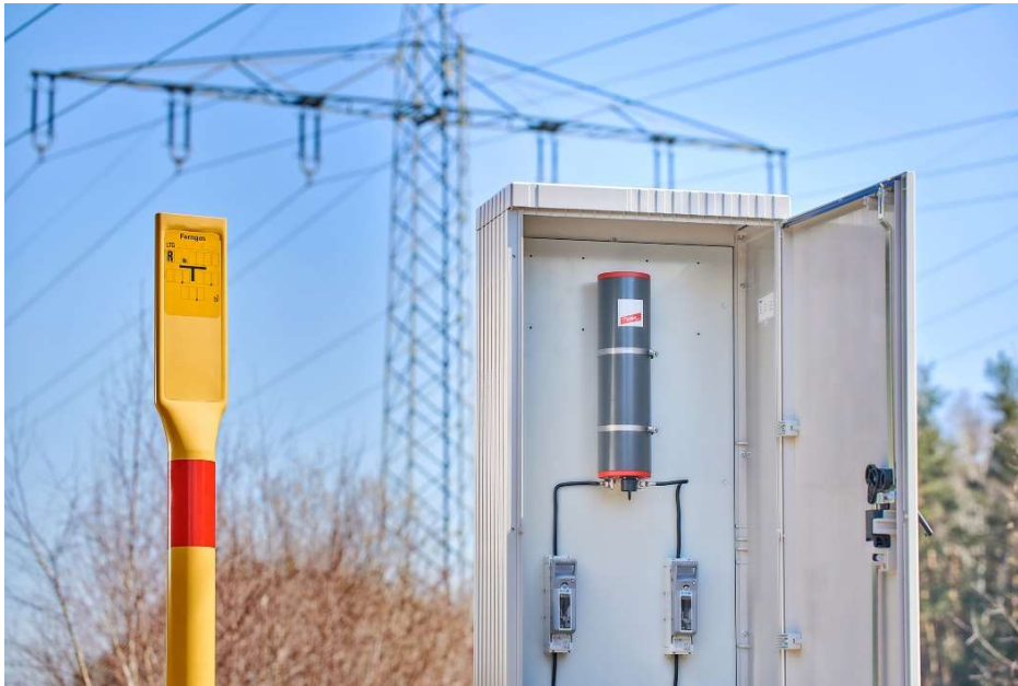
Bild: Die Abgrenzeinheit DASD 45 LP 100 T schützt sicher bei Fremdspannungsbeeinflussung unterschiedlichster Störquellen
