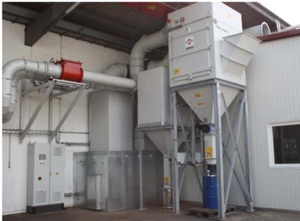
**Bild 1:** An den Putz- und Kontrollstrecken der Stahl-/Aluminium-Fertigung ist eine neue Trockenabsaugung im Einsatz. Sie ist besonders effizient und leise
