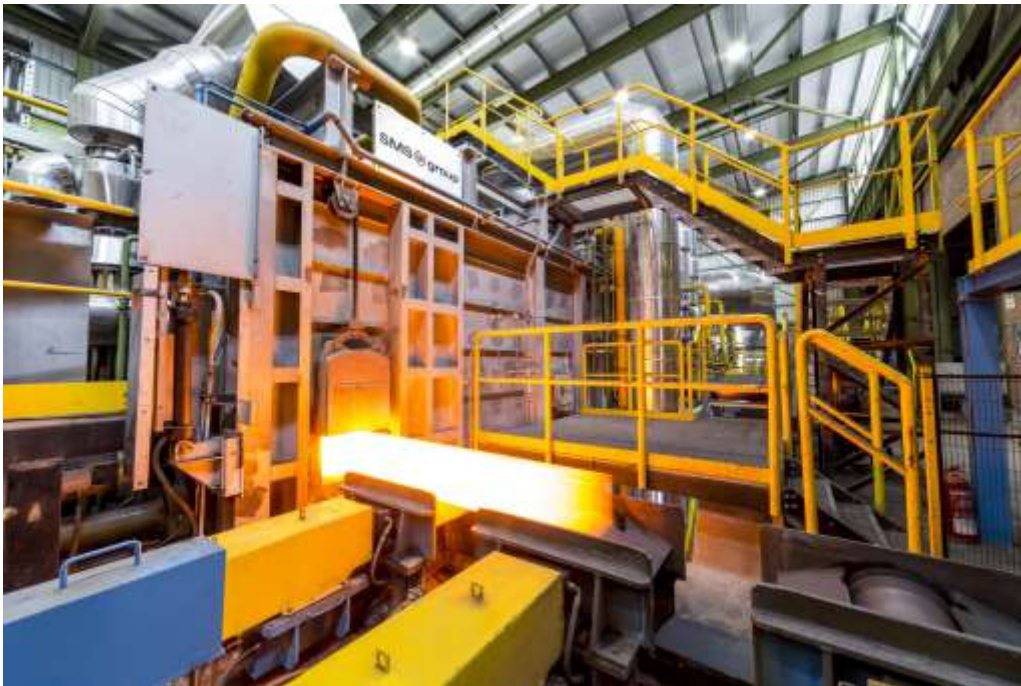
SMS group installierte einen neuen Hubbalkenofen mit den zugehörigen Einlauf- und Auslaufanlagen.
