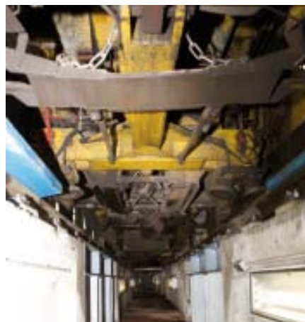
DIE HYDRAULISCHEN VERBINDUNGSELEMENTE mussten in einem ersten Arbeitsschritt freigelegt werden – dafür wurde die Maschine aufgebockt und viel Technik ausgebaut.
