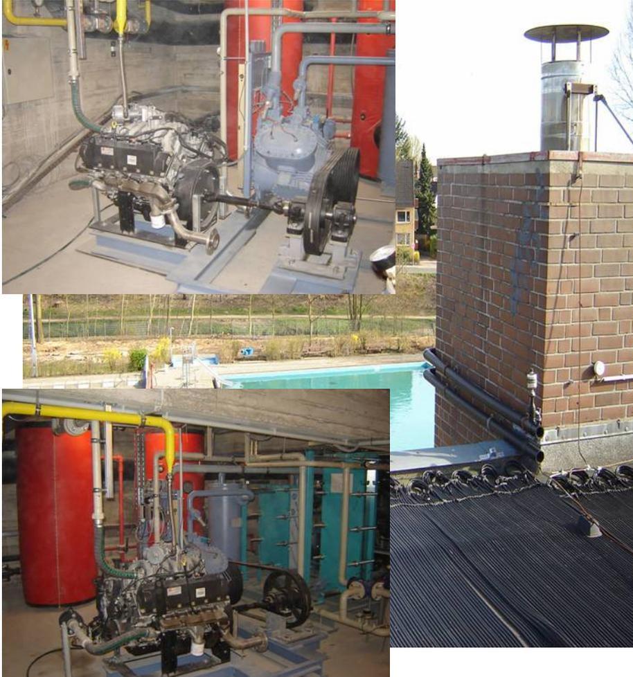
2007 ging in Hamburg bei der Bäderland Gruppe die erste gasmotorbetriebene Solarabsorber-Wärmepumpenanlage in Betrieb:
