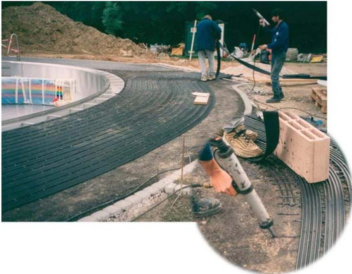
Ist der Untergrund vorbereitet, kann begonnen werden die klassischen **EPDM-Absorbermatten** auf dem Belag zu verkleben. Für diese Aufgabe wird derselbe Kleber verwendet, der auch dazu dient die Absorbermatten auf dem Dach zu montieren.
