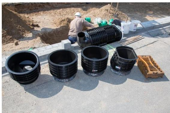
Das Straßenablaufsystem ACO Combipoint PP zeichnet sich durch Flexibilität, Widerstandsfähigkeit, Langlebigkeit, das geringe Gewicht und die Wasserdichtigkeit aus. Die nach dem Baukastenprinzip von Betonbauteilen nach DIN 4052 entwickelten Ablaufkörper erleichtern bereits den Planern durch ihre flexible Einsetzbarkeit die Arbeit. Ob Kurzform, Langform, Nassschlamm – die ca. 35 cm hohen Elemente lassen sich zeitsparend und passgenau für jede örtliche Baugegebenheit
