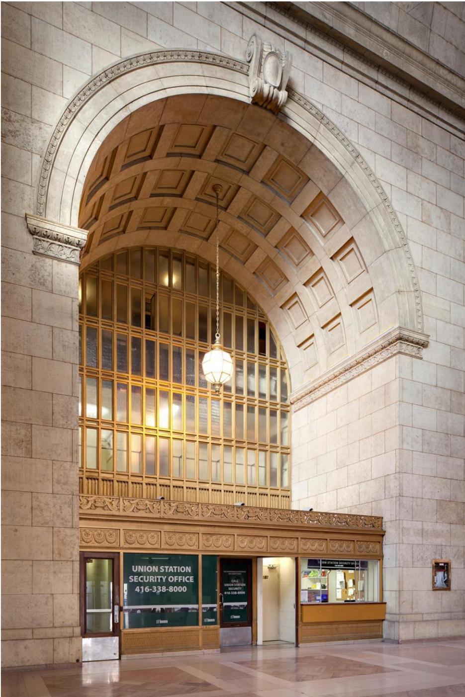
Mittels Arte Mundit konnten die Wände im Inneren der Union Station in Toronto während des laufenden Betriebs gereinigt werden.
