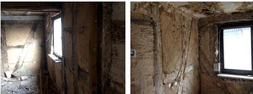
00 - Untergrund - abgeschlagener Altputz.JPG
