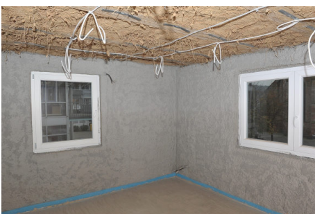
01 - mit Ausgleichsputz vorbereiteter Untergrund.JPG
