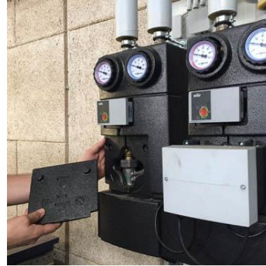
Bild Nr. 10-08 MK_KL-Heizungsregler.jpg. Verschalungsteile für Heizungstechnik. Die Werkzeuge dafür fertigt Keiels umweltbewusst aus Aluminium.
