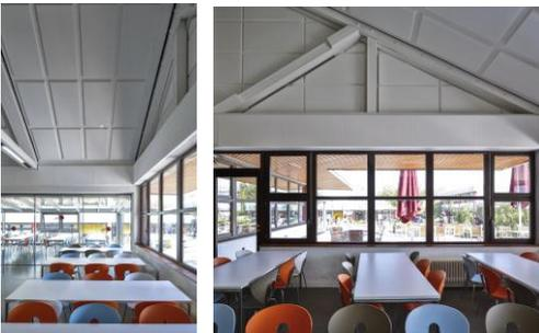
Architektonisch angepasst: In die Ausfachungen der Holzbalken-Dachkonstruktion wurden Melapor-Panel geklebt. So bleibt die Architektur sichtbar – bei optimaler Schallabsorption.
