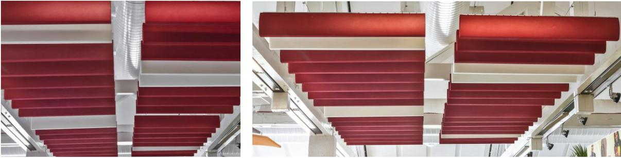
Gut geschützt: Die eng nebeneinander aufgereihten Baffle absorbieren einen Großteil des Schalls im lärmintensiven Bereich der Essensausgabe, den Rest schlucken die darüberliegenden Panel.
