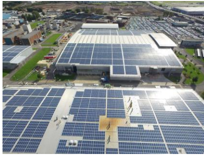
Foto: Die neue PV-Großdachanlage die auf den Dächern der Rolls-Royce Werke errichtet wurde, liefert eine Nennleistung von 3,42 MWp.
