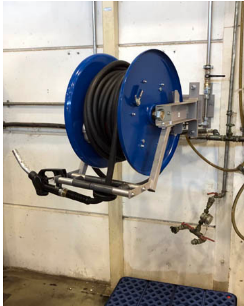
Bild Nr. 23-05 OE_GE-Pistole.jpg Zentralversorgung mit Oemeta-KSS und Vor-Ort-Befüllung mittels flexibler Schlauchaufroller und Abgabepistolen bei Gehring.
