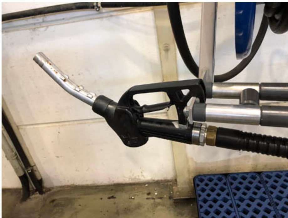
Bild Nr. 23-06 OE_GE-Pistole2.jpg Cleverer Detaillösung: Weil die Abgabepistole umgekehrt arretiert wird, gibt es kaum noch Tropfenbildung am Boden.
