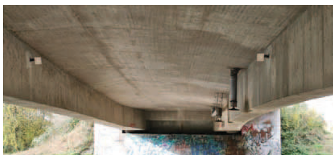
Abb. 5: Lucks Überbau Ansicht von unten
