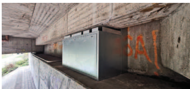
Abb. 4: Ansicht Widerlager mit Lasern
