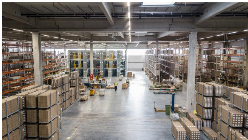
Lager Groß-Rohrheim Innen-Ansicht
