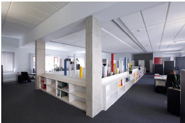
Großzügig und offen präsentiert sich der Büroraum im Obergeschoss. An die Decke geklebte CapaCoustic Melapor-Panelen verbessern die Akustik wie auch die abgehängten, runden Baffles im Luftraumbereich.
