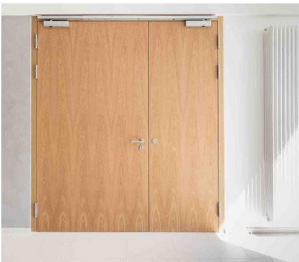
Links: Zweiflügelige Feststellanlage als dritter Zugang zum Ratssaal
