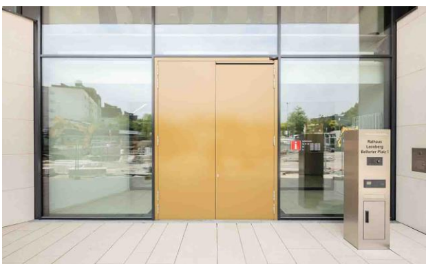
Barrierefrei: Haupteingang mit automatischen Drehtüranlagen mit „starken“ Powerturn-Antrieben
