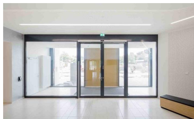
Barrierefrei: Haupteingang mit automatischen Drehtüranlagen mit „starken“ Powerturn-Antrieben
