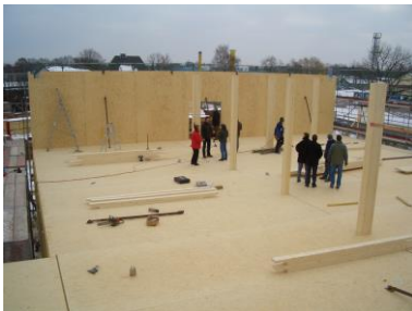
Schneller Baufortschritt durch großformatiges MagnumBoard
