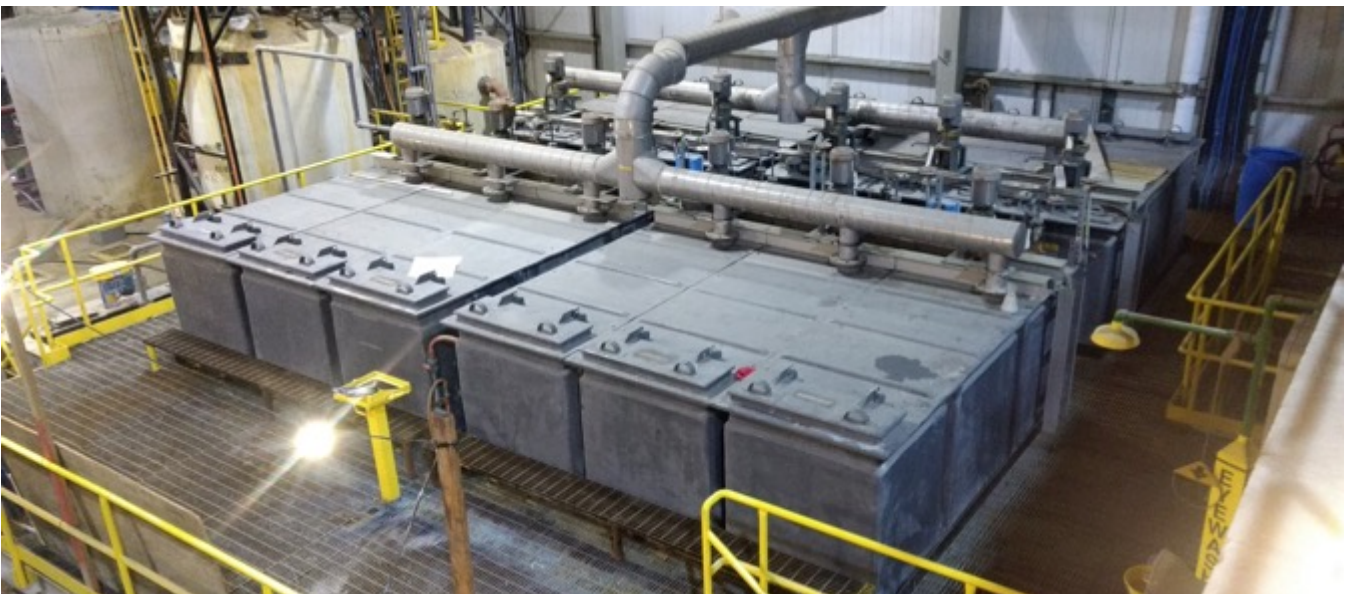
Wiederherstellung der Stromversorgung im Bereich der Lösungsmittelextraktion (SX)
