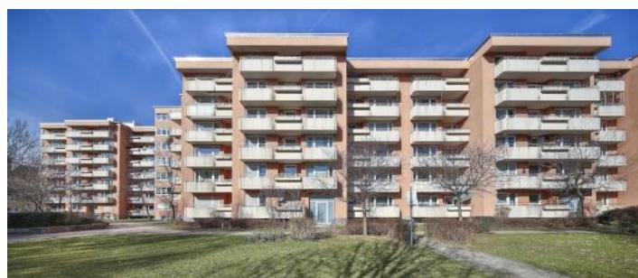
Der rückwärtige Bereich (Südseite) im unsanierten Zustand wirkt in die Jahre gekommen. Die Vielzahl an Balkonen hier gab den Ausschlag für das schlanke WDVS Capatect Dalmatiner Fassadenplatte S 024. So wird die Nutzfläche der Balkone nicht zu stark
