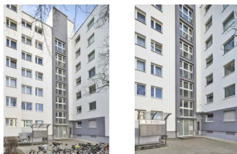
Die Eingangsbereiche wurden mit modernen Vordächern und Briefkastenanlagen versehen. Die Treppenhäuser heben sich im Farbton Spektrum 3D Eisenoxid Schwarz 30 gegen das Kühlweiß der Fassaden ab, sie setzen Akzente und bieten Orientierung.
