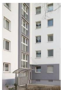
Die Dämmung ragt nur wenig über den ungedämmten Sockel hervor und trägt mit ihren zehn Zentimeter Dicke nicht so sehr auf. Das kommt auch dem Lichteinfall durch die Fenster zugute.
