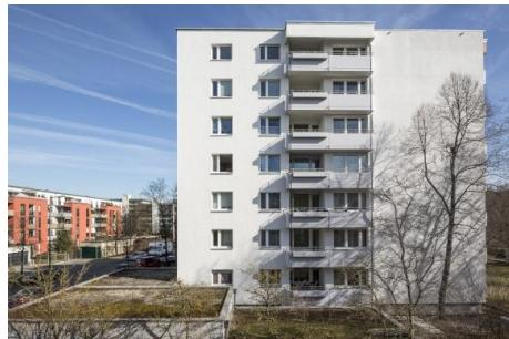
Die Westseite nach der Sanierung: Die Balkone haben dank des schlanken WDVS S 024 wenig Nutzfläche verloren. Das gedämmte Gebäude hebt sich mit seiner modernen, zurückhaltenden Farbgebung von den farbig gestalteten Nachbargebäuden ab.
