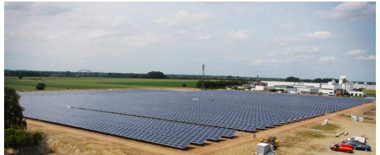
[Bildunterschrift] Zukunft statt Zucker – auf dem Gelände der ehemaligen Zuckerfabrik in Groß Munzel hat AS Solar die größte Photovoltaikanlage der Region gebaut. (Datei: as_solar_gross_munzel.jpg)
