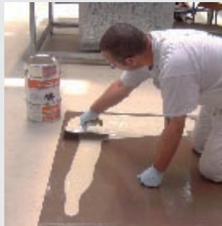
Auf die grundierte Fläche lässt sich das Material mit der Glätt scheibe „über's Korn ziehen“.
