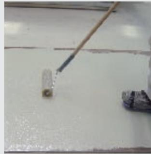
Nass-in-nass wird die Hartkornschnitz mit der Moltopren- oder Strukturwalze im Kreuzgang verteilt. Hierzu Caparol-Anwendungstechniker Juan Morales: „Das Material lässt sich äußerst rasch verarbeiten.“
