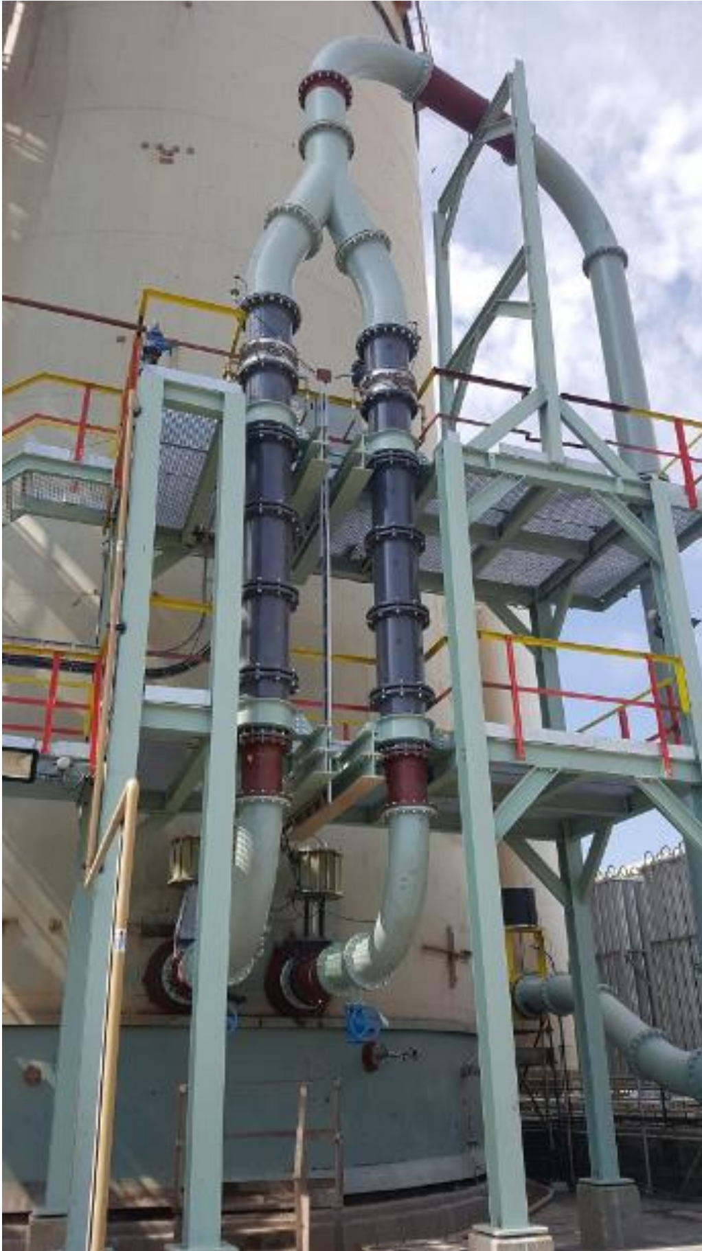
Abbildung 4: Aachen™-Installation – Goldmine, Beispiel 2
