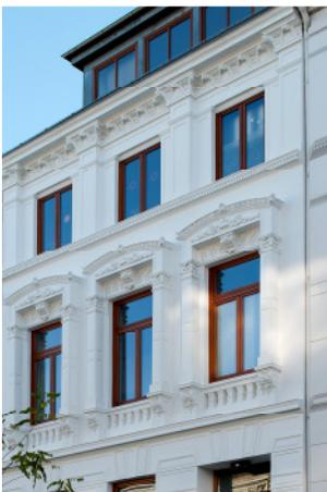
Der Farbanstrich lässt die alte Bausubstanz in neuem Glanz erstrahlen. Die Wiederherstellung der Schönheit der Fenstergewänder mit ihrem Stuckwerk verlangte den Handwerkern Geduld und Präzision ab.
