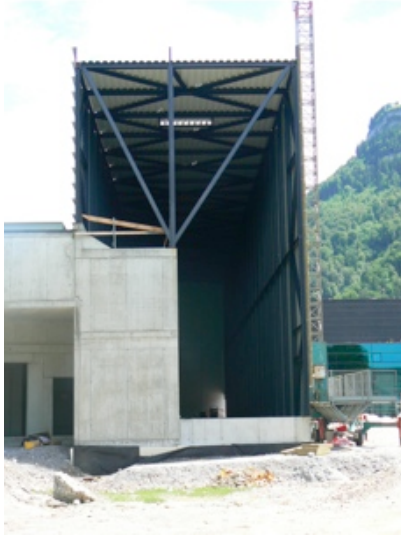
Bild 3: Das eingassige Hochregallager verfügt nach der Fertigstellung über rund 1.316 Palettenstellplätze.
