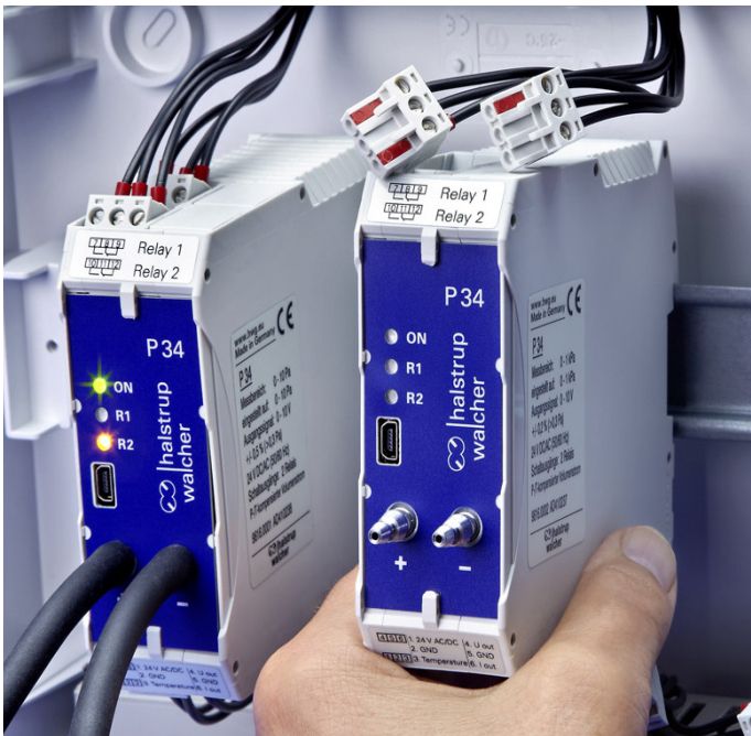
Abb. 2: Schaltschrank-Einbau des Volumenstrom-optimierten Messumformers P34
