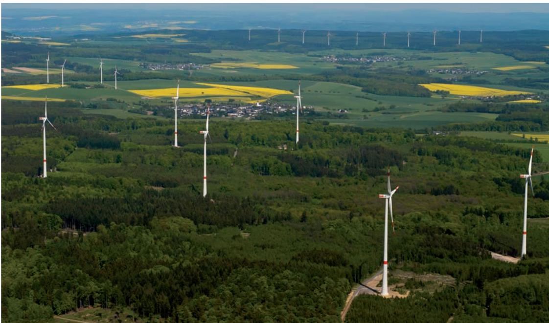
*Wegweisend für die Windkraftplanung an Waldstandorten ist der Windpark Klosterkumbd, den ABO Wind 2011 im Hunsrück errichtet hat. Die sechs Windenergieanlagen vom Typ REpower 3.4M104 mit einer Nennleistung von jeweils 3,4 Megawatt produzieren an dem Waldstandort jährlich rund 39 Millionen Kilowattstunden Strom – das entspricht dem Bedarf von mehr als 11.000 durchschnittlichen Haushalten.*
