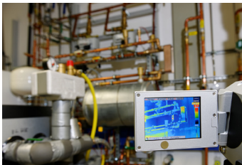
Thermographie der Leitungen eines KWK-Systems zur Identifizierung von Wärmebrücken.
