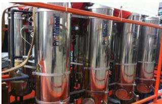
Bild 3: Die von ProMinent Fluid Controls Thailand entwickelte Wasseraufbereitungsanlage besteht aus verschiedenen mehrstufigen Filtern mit Rückspülung, Ultrafiltrationsanlagen, Umkehrosmembranen sowie einer UV –Anlage zur abschließenden Desinfektion des Trinkwassers.
