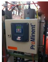
Bild 4: Mess- und Regelgerät DULCOMETER® zur Steuerung der unterschiedlichen Komponenten der Wasseraufbereitungsanlage
