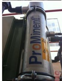
Bild 5: UV –Anlage zur abschließenden Desinfektion des Trinkwassers
