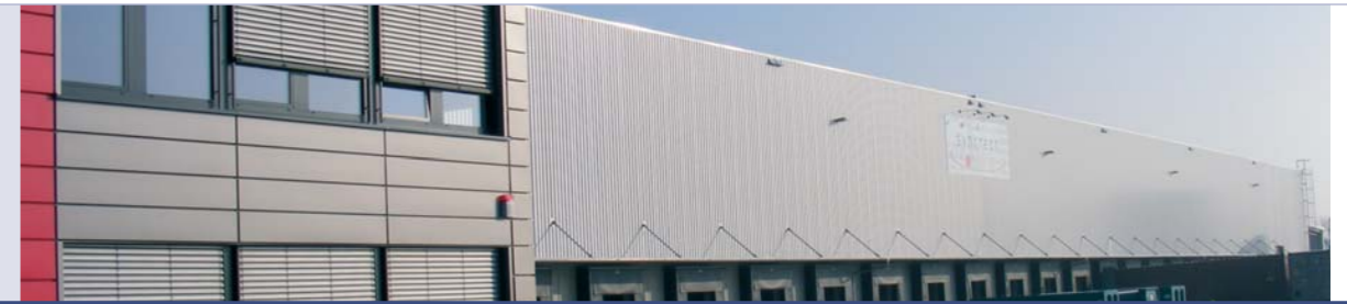
Auf den fertig gestellten ersten Bauabschnitt folgt die Erweiterung: Garbe baut für den Automotive-Dienstleister syncreon am Standort Wunstorf weitere 19.000 qm Hallenfläche.
