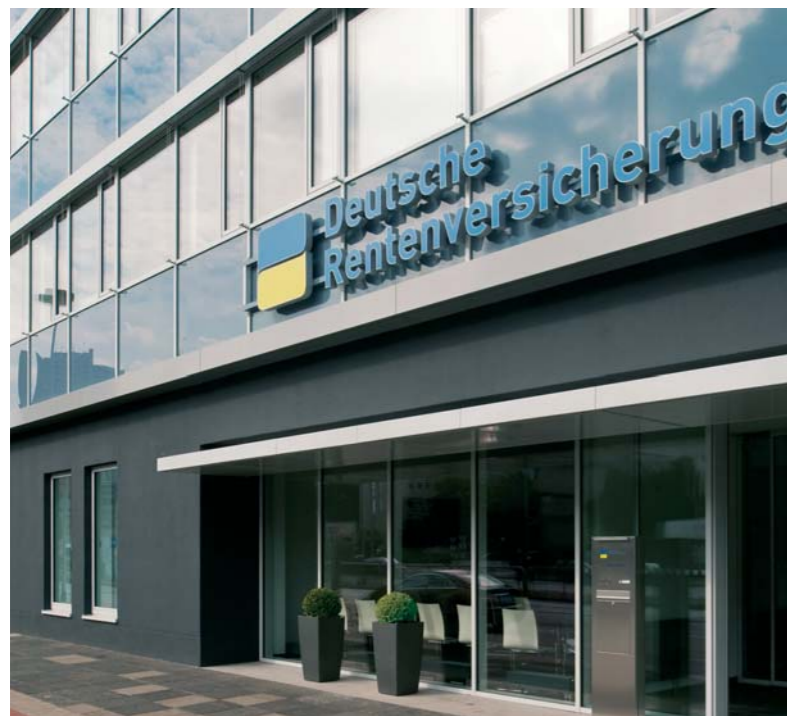
Komplett saniert - das Beratungszentrum der Deutschen Rentenversicherung an der Berliner Allee.
