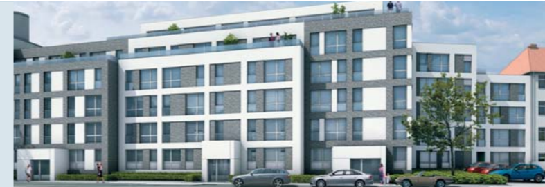
Lofts as you like - in der Calenberger Neustadt, direkt am Ufer der Leine, entwickelt Hochtief Solutions formart 40 Eigentumswohnungen im Loft-Stil.
