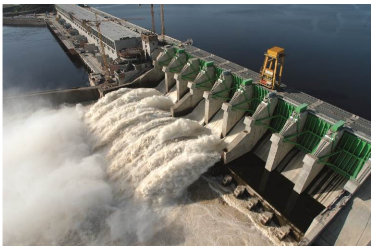
Abb.2: Wasser + Kraft = Wasserkraft: Caruachi-Wasserkraftwerk im venezolanischen Bundesstaat Bolivar
