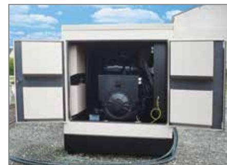
▲ das Design der Kühlluftöffnung schützt optimal gegen Wassereintritt
