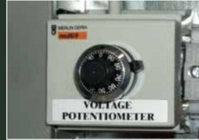
▲ Spannungsfeineinstellung über Fernpotentiometer
