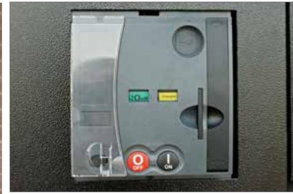
▲ Motorisierter Hauptschalter für die Synchronisierung von Stromerzeugern
