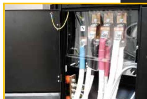
◀ Kupferschienensystem zum Auflegen der Netz-Lastkabel
