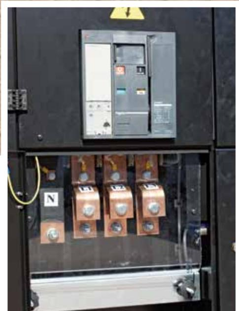
▲ Polycarbonat Schutzabdeckung für Kupferschiene
