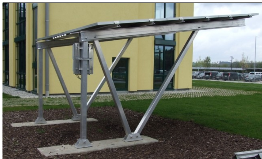
Solar-Carport von Schletter. Elektroautos können auf solchen überdachten Stellplätzen während des Parkens gleich Strom tanken. Die stabilen Konstruktionen halten z.B. schwerem Nass-Schnee und hohen Windlasten stand.
