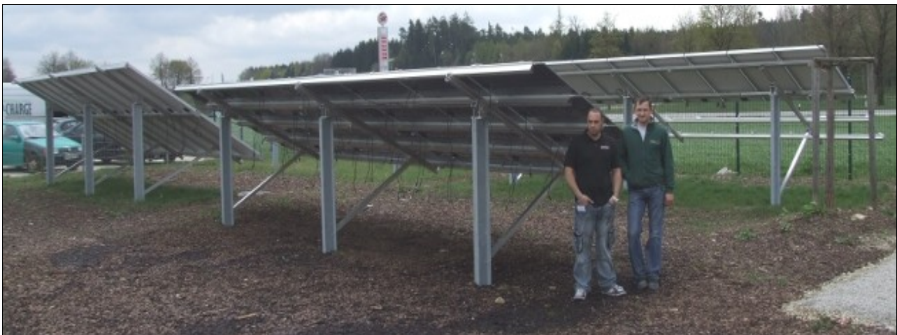
Denis Duckart und Andreas Stengert veranschaulichen die Höhe von Solarmodul-Freilandanlagen. Zusammen mit einfachen Fundamenten liefert Schletter die stabilen Unterbau-Konstruktionen.
