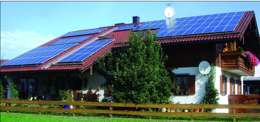
Nach Süden ausgerichtete Dachflächen sind ideale Standorte für Solarmodule auf Hausdächern.
