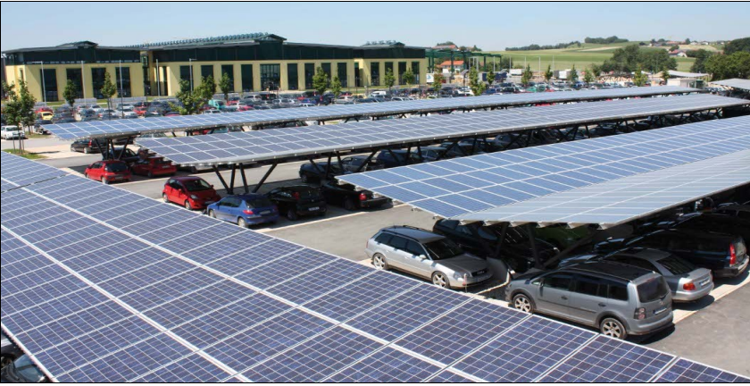
Solar-Carports auf dem Firmengelände der Schletter GmbH. Mit Ladesäulen und Elektroautos wird so Elektromobilität ermöglicht und gefördert.
