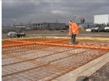
Drytech-Monteur befestigen DRYset-Injektionsprofile als Sollrisselemente Boden/Boden zwischen der Ober- und Unterbewehrung einer Abstellfläche für verunfallte LKW.
