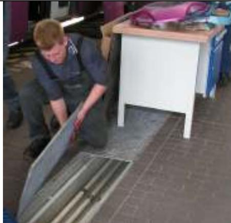
Zur Ölver- und Altölentsorgung wurden Beton-Bodenkanäle im offenen Querschnitt 40/40 cm als Weiße Wanne ausgeführt. Abgedeckt sind sie mit Blechabdeckungen, die einer Radlast von 4 to standhalten.
