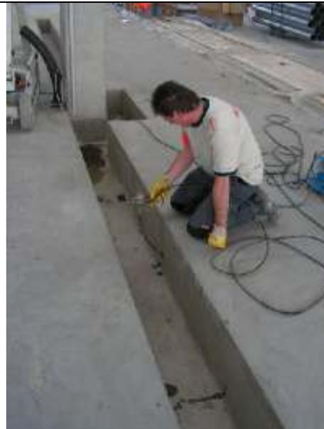
Ein Abdichtungstechniker von Drytech während dem Injektionsvorgang bei einem der Bodenkanäle für die Ölver- und Altölentsorgung.
