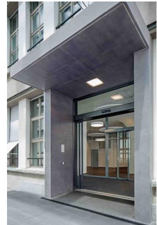
Der Zugang zur KV Zürich Business School an der Seitenfassade: Maximale Türöffnung bei begrenztem Platz: Vierflügelige automatische Teleskopschiebetür mit Slimdrive SLT-Antriebssystemen in Fluchtwegausführung
