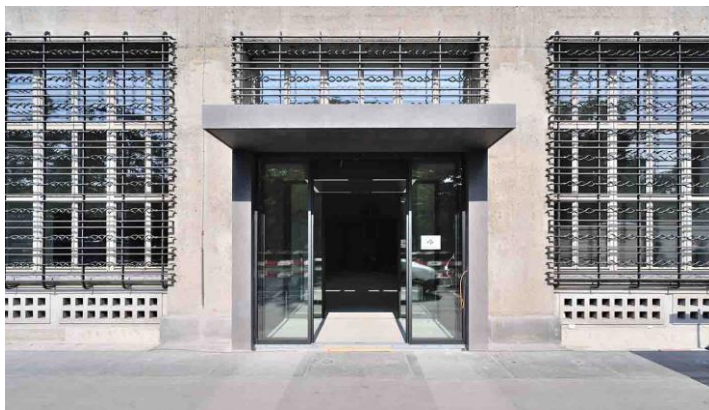
GEZE Türautomatik in den Eingangsbereichen des Sihlpost-Gebäudes
