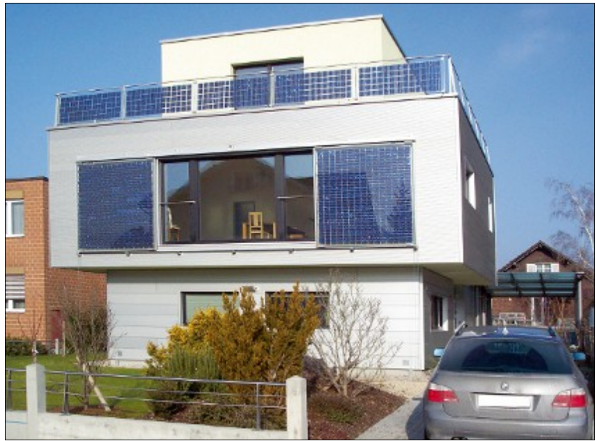
Großflächige Schiebeläden mit Solarmodulen – so produziert der Sonnenschutz gleich Strom.
