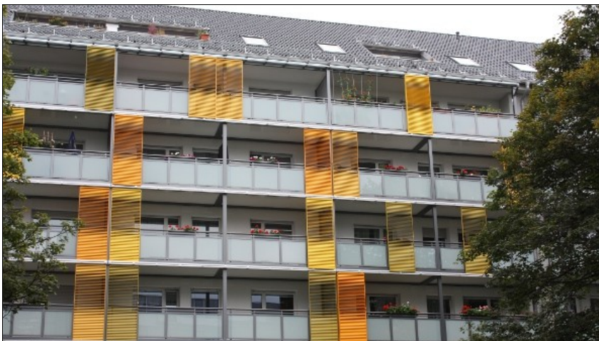
Schiebeläden als Sichtschutz und Beschattung, die eingesetzten Ovalstäbe (Bild rechts) sind auf Augenhöhe quergestellt, um den Bewohnern Ausblick zu ermöglichen.
