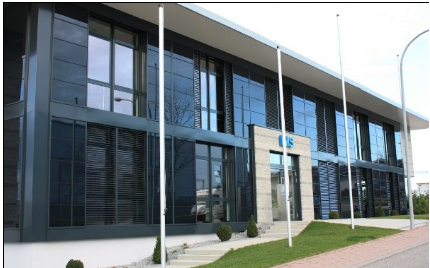
Fassade mit Solarmodulen. Bei Funktion, Design und Herstellung setzt Baier die Wünsche seiner Kunden zuverlässig um.
