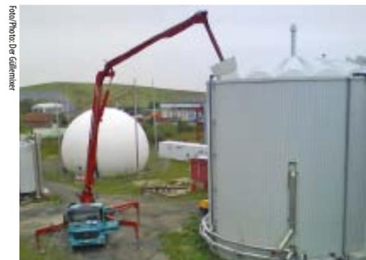
» Durch defekte, fest installierte Rührwerke innerhalb der Biogasanlagen, Güllebehältern und Deponien entstehen Schwimm- oder Sinkschichten, welche die Anlagen stark beschädigen können. Um das zu vermeiden müssen die Behälter richtig durchgerührt werden.
