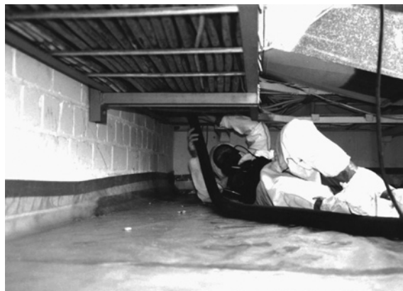
Sanierung eines asbest-belasteten Gebäudes
